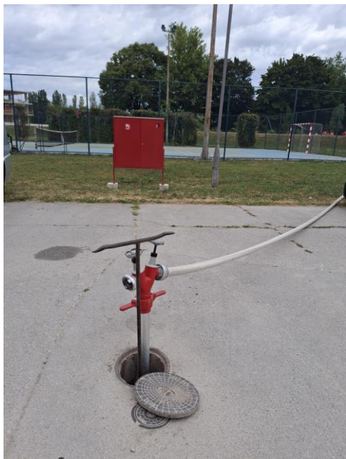
Postavljeni hidrantski ormarići
