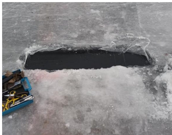
Popravak oštećenja uslijed pucanja gumene podloge i curenja punila.
