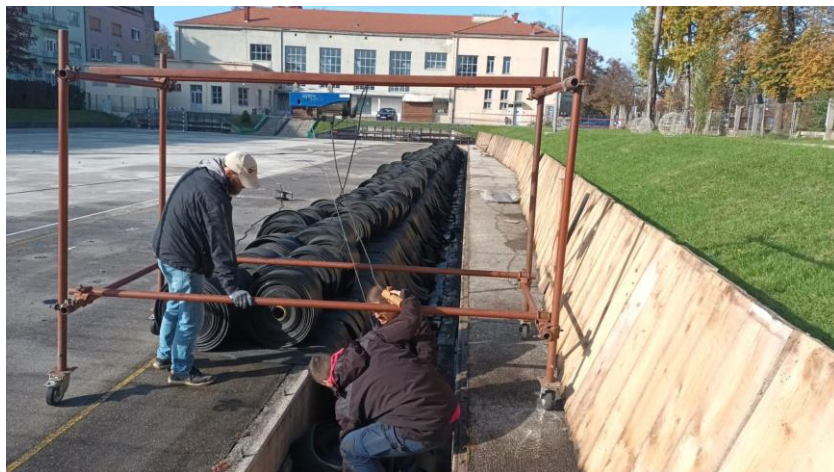
Priprema podloge za klizalište.
